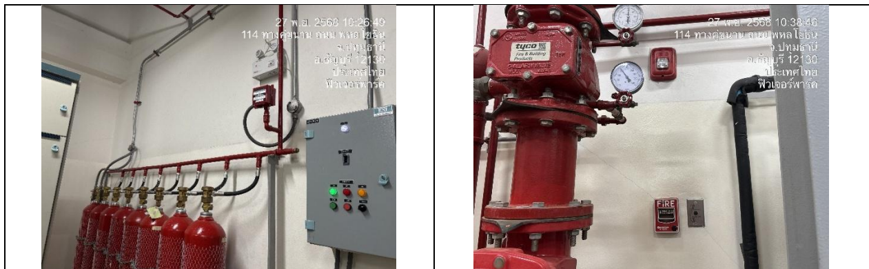
ระบบป้องกันอัคคีภัยสำหรับห้องไฟฟ้า
